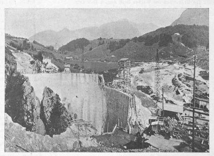
Abb. 1. Bogen-Staumauer in der Jogne-Schlucht bei Châtel Montsalvens.
