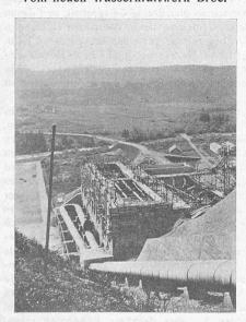
Abb. 2. Druckleitung und Maschinenhaus bei Broc.
