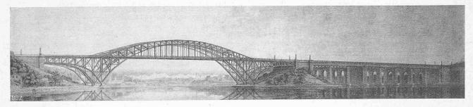
Abb. 11. Entwurf "Arsta Holmar"; durchgehend Eisenkonstruktion, Hauptöffnung 200 m weit. Gesamtbild vom Südufer aus gesehen.
