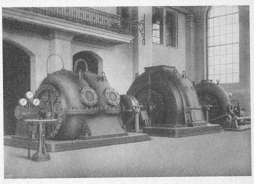
Abb. 4. Maschinengruppe von 4500 PS bei 735 Um/lmin des Kraftakkumulierungswerkes Viverone.
