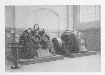
Abb. 5. Pumpengruppe von 1250 PS bei 960 Uml/min.
