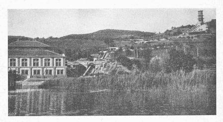
Abb. 1. Blick auf Maschinenhaus, Druckleitung und Wasserschloss.
