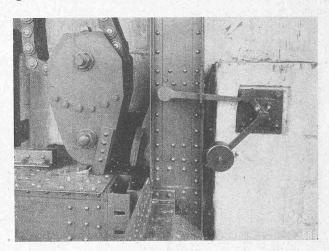
Abb. 35. Automatische Kupplung. Obere Schütze um 10 cm gehoben, zum Einhängen in die obere Stellung (auf Staukote).
