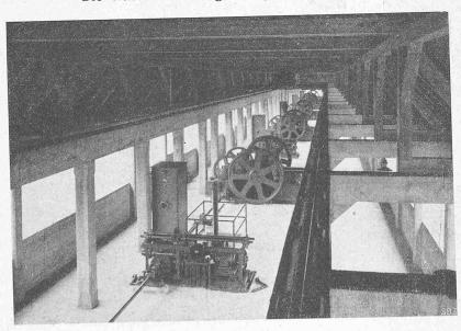
Abb. 37. Blick in den Bedienungsteg mit den Windwerken der Schützen. Lieferantin der Windwerke: "Giesserei Bern" der von Rollschen Eisenwerke.
