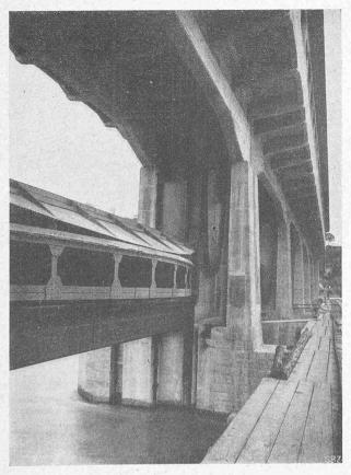
Abb. 30. Doppelschütze von der Unterwasserseite, in Stellung III.
