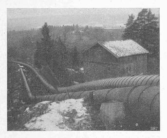
Abb. 6. Hölzerne Druckleitung (rechts) des Kraftwerkes Eidsvold, Durchmesser 1000 mm,
