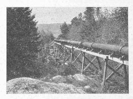
Abb. 2. Pumpwasserleitung der Zellulosefabrik Moelven. Spiralumschnürte hölzerne Muffenröhren, Durchmesser 480 mm.
