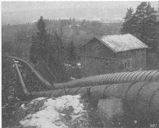
Abb. 6. Hölzerne Druckleitung (rechts) des Kraftwerkes Eidsvold, Durchmesser 1000 mm, Druckhöhe 48 m; zum Ersatz der links davon liegenden älteren Eisenrohrleitung.
