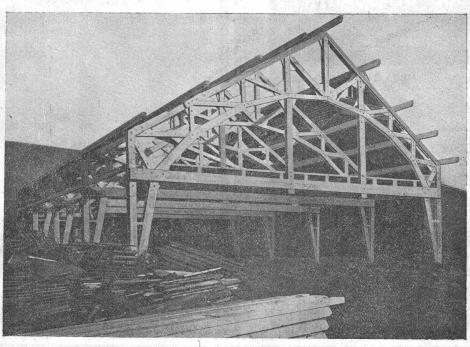
Bau in Zofingen Widmer Söhne. Zweigelenkbinder mit aufgehängterDecke
