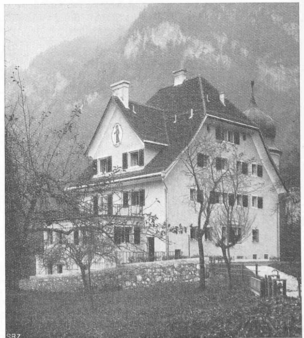
Abb. 2. Ost- und Nordseite des „Waldschlössli“ bei Glarus.
