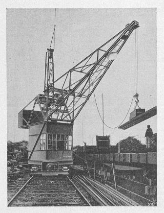
Abb. 1, Normaler Drehkran mit Lasthebemagnet,
