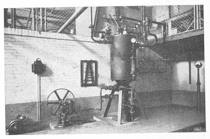
Abb. 4. Hochspannungs-Revelkessel-Anlage für 650 kW bei 2250 V.
