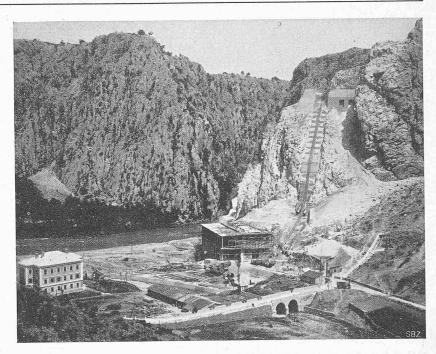
Abb. 25. Wasserschloss, Druckleitung und Maschinenhaus im Bau.
