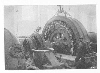
Abb. 29. Maschinengruppe im Bau (\$000 PS-Turbinen-Laufrad).
