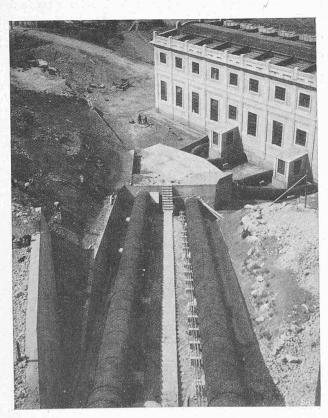
Abb. 26. Blick auf den untern Teil der Rohrleitung.
