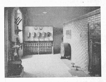
Abb. 9. Elektrisch geheizter Wärmespeicher für eine Pumpen-Warmwasserheizung, erstellt von der Firma Gebr. Sulzer in der Bronzewarenfabrik A.-G. Turgi.
