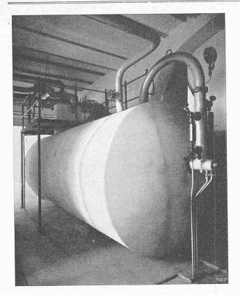
Abb. 11. Hochdruck-Dampfspeicher in der Seidenfärberei Rob. Schwarzenbach & Cie. in Thalwil.
