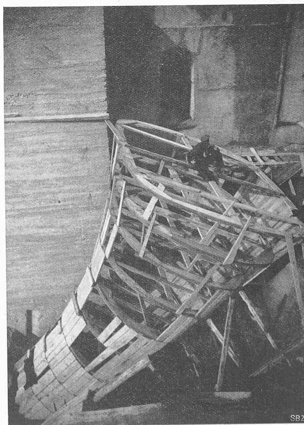
Abb. 23. Schalung zur Betonierung eines Einlauftrichters der Rohrleitung.
