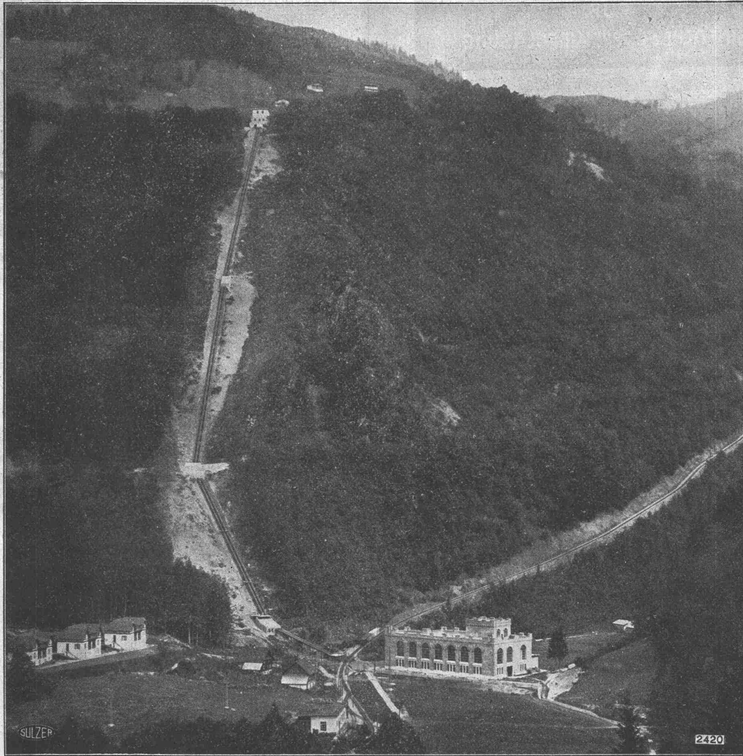
Hochdruckrohrleitungen des Elektrizitätswerkes Obermaif-Engelberg der Stadt Luzern
