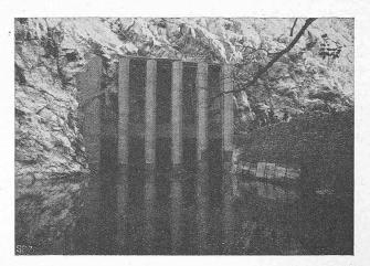
Abb. 9. Einlauf des Umgehungstunnels, rechts I. provisorisches Wehr.
