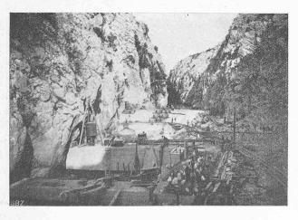
Abb. 13. Caissons des definitiven Wehrs, dahinter das II. prov. Wehr.
