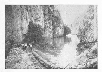
Abb. 8. Erstes provisorisches Wehr im Bau (Blick flussaufwärts).
