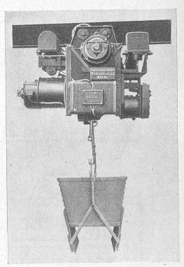
Abb. 4. Elektro-Flaschenzug, kombiniert mit Transportkübel für Sammelgüter.
