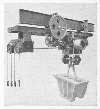
Abb. 3. Zweimotoren-Unterflansch-Laufwinde von 2500 kg Tragkraft.
