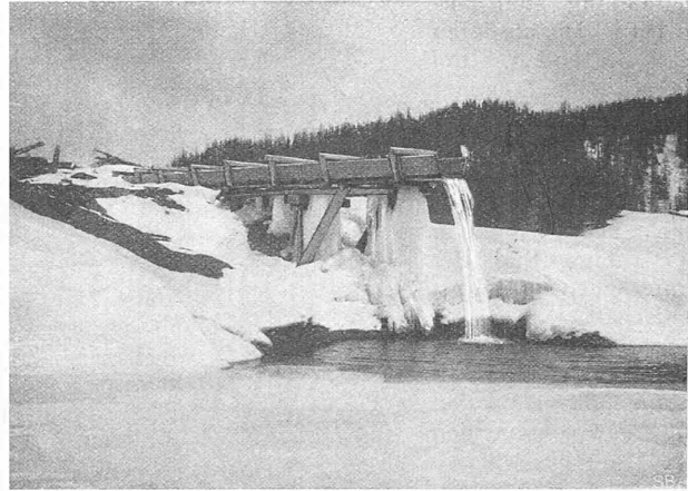
Abb. 2. Mündung des Todtalp-Baches in den gesenkten Davosersee während der Schneeschmelze (die Holzrinne verhindert die Schluchtbildung).
