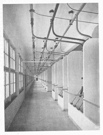
Abb. 132. Sammelschienen-Raum für 8000 V.
