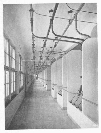
Abb. 132. Sammelschienen-Raum für 8000 V.
