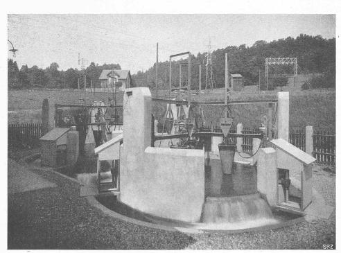
Abb. 125. Belastungswiderstände für je 12000 kW des Kraftwerks Gösgen.
