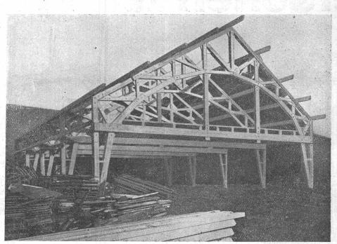
Bau in Zofingen fiir Widmer Söhne. Zweigelenkbinder mit aufgehängter Decke
