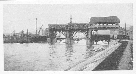
Abb. 27. Bau des Dienststeges: über Oeffnung 1 vollendet, in Oeffnung 2 und 3 Verschalungsgerüst. (16. XII. 1915.)
