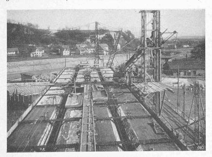
Abb. 26. Verschalungsgerüst für die Tafel des Dienststeges über Oeffnung 2 und 3. (15. XI. 1915.)
