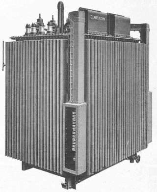
Abb. 12. Der Stufentransformator mit regendichtem Oelbehälter.
