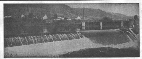
Hydraul. Dachwehr des Elektrizitätswerkes Bruck a/ Mur. Zwei Oeffnungen von je 22 Meter Länge und 1,10 Meter Stauhöhe.
