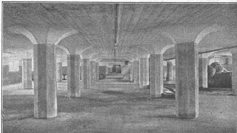
Unterzugslofe Decke, System Maillart. Erdgeschoss des Lagerhauses Altdorf der Schweizer, Eidgenossenschaft.
