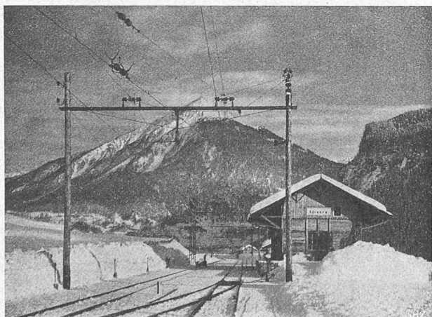
Abb. 1. Zweispurige Station (Alvaneu) mit Holzmasten.
