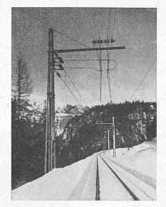
Abb. 3. Eisenmast mit stromlosem Trennstück und Endabfangung der Leitung.
