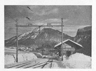
Abb. 1. Zweispurige Station (Alvaneu) mit Holzmasten.
