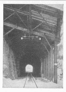
Abb. 7. Streckentrennung in einer Schutzgalerie.
