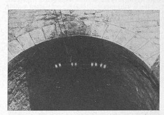
Abb. 11. Leitungs-Stützpunkt in niederem Tunnel-Profil.
