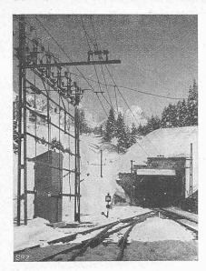
Abb. 13. Typus des offenen Schaltergerüstes.
