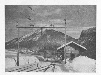
Abb. 1. Zweispurige Station (Alvaneu) mit Holzmasten.
