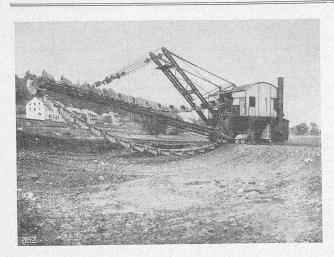
Abb. 104. Beginn der Baggerung für die Maschinenhaus-Baugrube. 31. VII. 1914.
