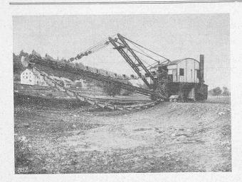
Abb. 104. Beginn der Baggerung für die Maschinenhaus-Baugrube. 31. VII. 1914.
