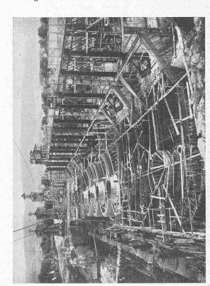
Abb. 99. Im Vordergrund Armierung des Maschinenhaus-Bodens. Im Hintergrund die Verschalungen für die Einlaufspiralen 3 bis 6. 1. VII. 1916.
