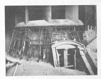
Abb. 97. Armierung unter dem festen Leitapparat, mit den durch die hohlen Schaufeln gehenden Verankerungseisen mit Spannschlössern. Rechts der Zugang zum Saugrohr. 15. V. 1917.
