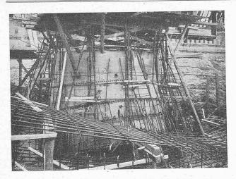
Abb. 95. Spannschlösser zur Verankerung des festen Leitapparates (provisorischer Einbau zur Sicherung der Lage der Stäbe im Beton des Unterbaus). 7. V. 1916.
