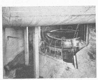
Abb. 96. Inneres einer Turbinenkammer mit provisorischen Säulen für die Abstützung des Maschinenhaus-Bodens. Rechts der Turbinen-Untersatz mit Zugang zum Saugrohr. 27. X. 1916.
