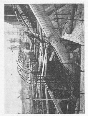
Abb. 100. Armierung für die Einspannung des Maschinenhaus-Bodens bei den Turbinen 1 und 2 in den Betonkörper des Vorbaus (Einlauf rechts). 1. VII. 1916.
