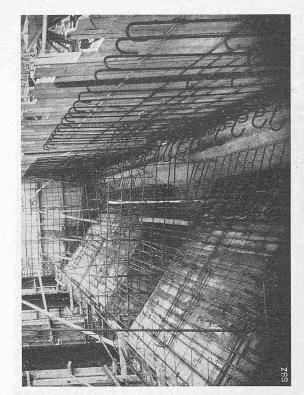
Abb. 101. Armierung für die Einspannung des Maschinenhaus-Bodens bei den Turbinen 3 und 4 in den Betonkörper des Vorbaus und in die Pfeiler (Einlauf links). 17. IX. 1916,
