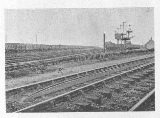
Abb. 1. Kontaktrampe des Warnungsignals der Great Eastern-Bahn,
