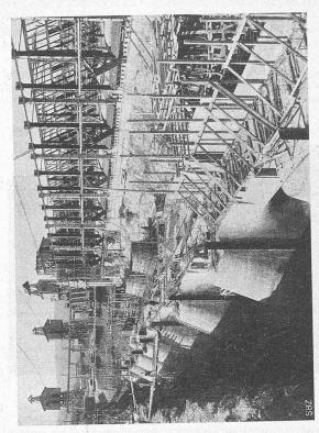
Abb, 90. Unterbau betoniert bis auf Höhe Unterkant Saugrohrpanzerung. Rechts Rechenunterbau und Führungen der Einlaufschützen. 29.1V. 1910.
