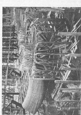
Gerippe für die Verschalungen der Einlaufspiralen der rechtsseitigen Turbinen 7 und 8. 22. V. 1916. 92.
