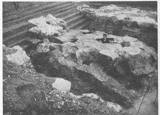
Abb. 86. Vortertiäre Erosionsfläche mit 1,0 bis 1,4 m tiefen Löchern und Fundament-Verzahnungen nach Abb. 85.
