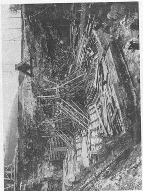
Abb. 87. Verschalungen für die Pfeilerköpfe der Turbinenausläufe 1 bis 3, sowie betonierte Sohle der Saugkrümmer. — 27. XII, 1915.
