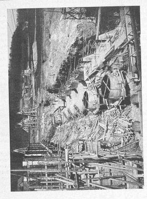
Saugrohrpanzerungen für die Turbinen 1, 2, 7 und 8, Verschalungen der Saugkrümmer für die Turbinen 3 bis 6. — 28. III. 1916.
