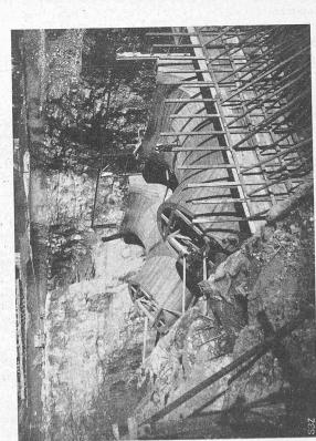
Abb. 83. Verschalungen für die Saugkrümmer der linksseitigen Turbinen 1 und 2 mit den Führungen für die Dammbalken-Abschlüsse. — 28. I. 1916.
