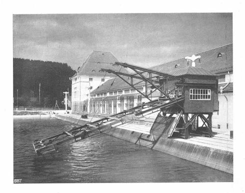
ANSICHT VON DER OBERWASSERSEITE, MIT DER RECHENREINIGUNGSMASCHINE
