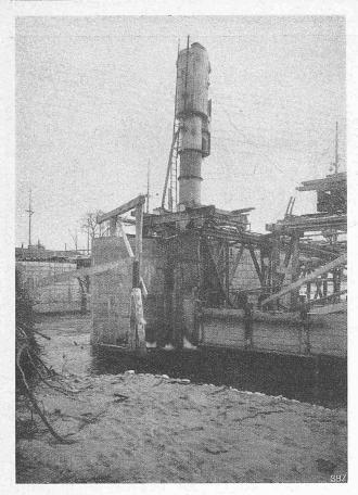
Abb. 20. Fugenschluss-Taucherglocke im Betrieb in Oeffnung 2 (27. III. 15).
