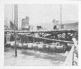
Abb. 15. Schwellen-Caisson 1, Schneide 380,87, W.-St. 388,60 (11. IV. 14).
