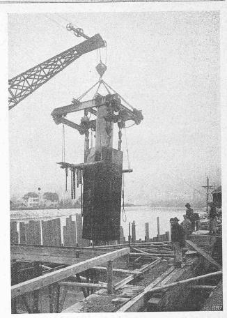
Abb. 19. Rollwagen mit Fugenschluss-Taucherglocke (8. XI. 15).
