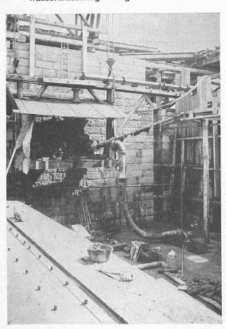
Abb. 18. Verkleiden der Schwelle 2, links hängende Pumpanlage (1. IV. 15).
