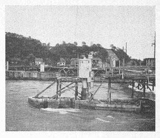
Abb. 16. Pfeiler IV fertig abgesenkt und ausbetoniert (2. V. 14).
