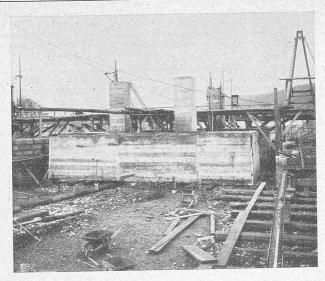
Abb. 13. Betonierte Schwellen-Caissons in Oeffnung 1. (28. II. 1914.)
