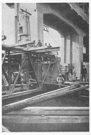
Abb. 21. Fugenschluss beendet, in Oeffnung 4 (16. III. 1916).
