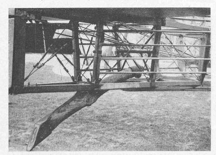
Abb. 12. Sporn am hintern Ende eines Flugzeugrumpfs amerikanischer Bauart.
