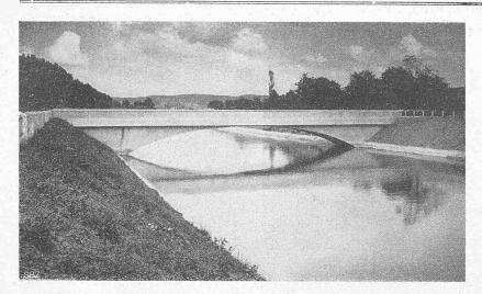
Abb. 70. Strassenbrücke über den Oberwasserkanal bei Km. 4,08 mit auskragendem Betonkanal für die Ueberleitung des Mühlebaches.
