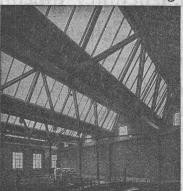
Reingelenkartig wirkende, elastisch arbeitende Holzkonstruktionen. Das Schwinden und Quellen (Arbeiten) des Holzes vollzieht sich spannungs-- Keine Materialüberbeanspruchungen. Kostenersparnisse.
