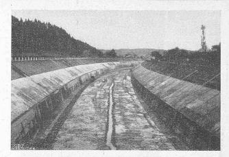
Abb. 59. Fertiges Kanalprofil in der Felspartie bei Km. 4,3.
