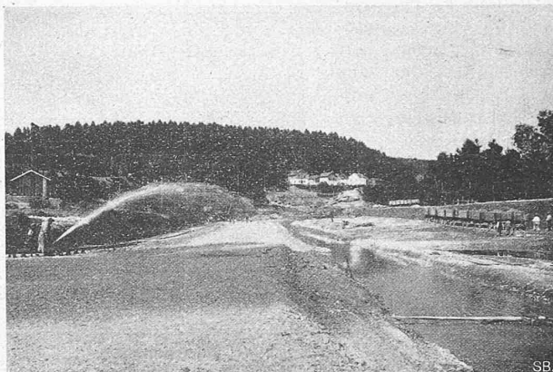
Abb. 55. Bespritzen des rechtsseitigen Damms bei Km. 3 etwa auf Kote 381,00 (vergl. Abb. 51).
