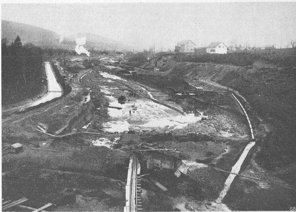
Abb. 52. Aushub des Schlamm sandes bis 4 m unter Terrainlinie für das rechte Dammlager, gesehen ab Km. 3,2.
