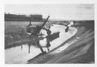
Abb. 48. Kanalpartie tei Km. 9 bis 10 im Bau. An der Böschung rechts Betonverkleidung unvollendet (26. XI. 15).
