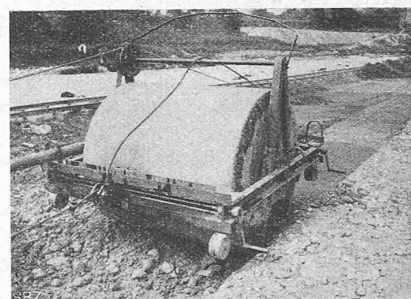
Abb. 54. Einrollige Walze mit Seilbetrieb für das Walzen des Lehmkerns.
