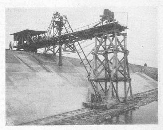
Abb. 49. Betonaufzug für die Betonierung der Böschungen.
