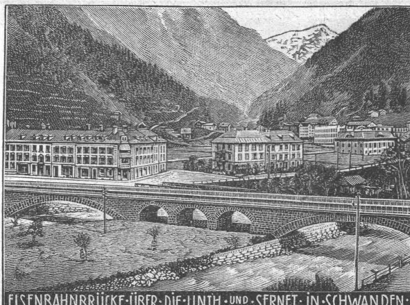
EISENBAHNBRÜCKE ÜBER DIE LINTH-UND-SERNFT IN SCHWANDEN
