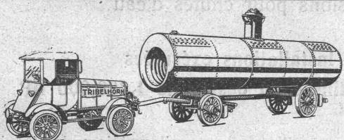
Elektro-Traktor, Normal-Anhängelast 8 bis 10 Tonnen, Steigungsüberwindung bis 15%
