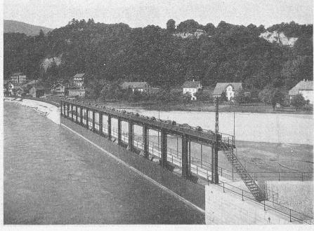
Abb. 44. Einlauf Bauwerk des Oberwasser-Kanals des Kraftwerks Gösgen.
