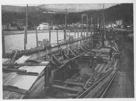
Abb. 42. Fundament-Aushub der Einlauf-Schwelle.
