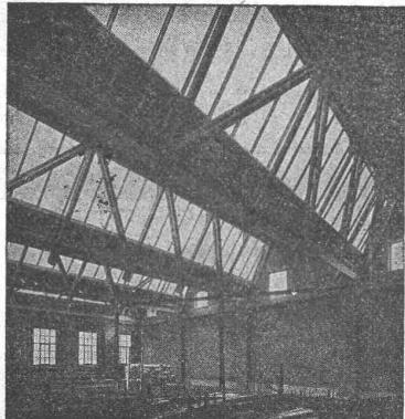
Reingelenkartig wirkende, elastisch arbeitende Holzkonstruktionen. Das Schwinden und Quellen (Arbeiten) des Holzes vollzieht sich spannungslos. — Keine Materialüberbeanspruchungen. Kostensparnisse. .
