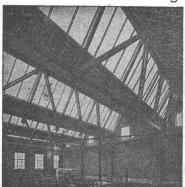
Reingelenkartig wirkende, elastisch arbeitende Holzkonstruktionen. Das Schwinden und Quellen (Arbeiten) des Holzes vollzieht sich spannungslos. — Keine Materialüberbeanspruchungen. Kostenersparnisse.
