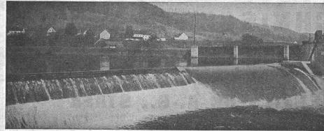
2 Oeffnungen, je 22 m lang, durch Stauwasser vom Ufer aus ohne Dienststeg bedienbar, bestens bewährt bei starkem Eisgang.
