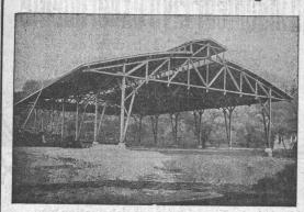
Reingelenkartig wirkende, elastisch arbeitende Holzkonstruktionen. Das Schwinden und Quellen (Arbeiten) des Holzes vollzieht sich spannungslos. — Keine Materialüberbeanspruchungen. Kostenersparnisse.
