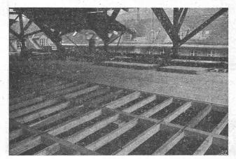
für Flachbedachung ( Patent) bildet ein Ersatz für Holzschalung. Wegen der vorzüglichen Beschaffenheit des Eternit (Wasserbeständigkeit, Widerstandsfähigkeit gegen Ersticken und gegen Fäulnis), eignet sich das "Eternitunterdach" für Flachbedachung besonders für Flachdächer bei:
