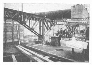
Abb. 10. Montage der Melan-Träger und der Wehrwalze (Oktober 1917).
