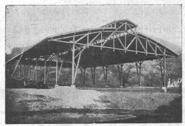
Reingelenkartig wirkende, elastisch arbeitende Holzkonstruktionen. Das Schwinden und Quellen (Arbeiten) des Holzes vollzieht sich spannungslos. — Keine Materialüberbeanspruchungen. Kostenersparnisse.
